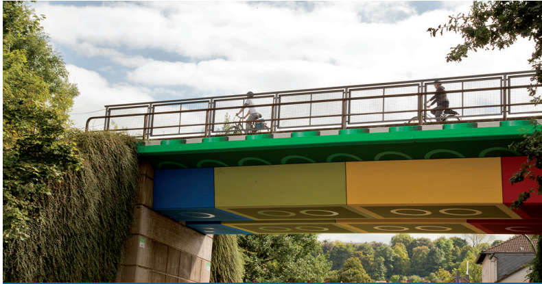
Brücke der Nordbahntrasse
